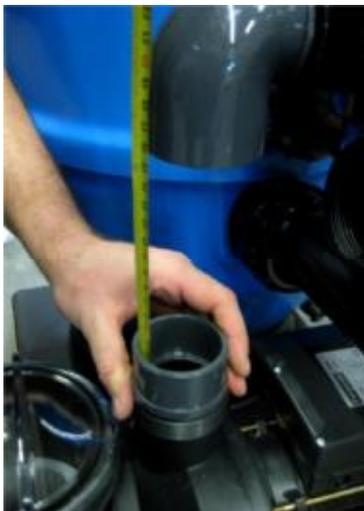
Geben Sie nun eine, der bei der Pumpe mitgelieferten Verschraubungen auf die druckseitige Öffnung und messen Sie aus dem Inneren der Verschraubung hoch zur Kante des 90° Winkels. Das Ergebnis addieren Sie zu der Markierung am PVC-Rohr und schneiden das Rohr auf die richtige Länge zu.
