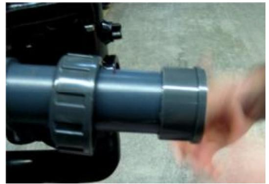
Die übriggebliebene Verschraubung ist für die Ansaugöffnung vorgesehen - sie wird mit demselben Prinzip mit einem PVC-Rohr DA50 an der Pumpe befestigt.
