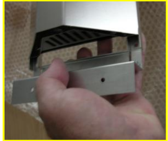
Einsetzen der Montagewinkel
