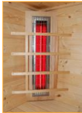
Eckeinbau in eine Holzplatte mit Aluminium-Aluminiumrahmen und Berührungsschutzgitter
